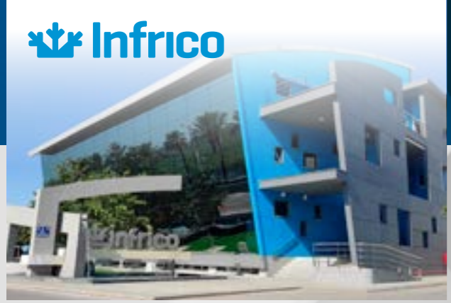
Oficinas centrales Headquarters
